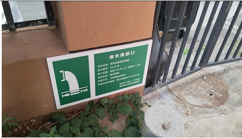
废水排放口及标识标牌
