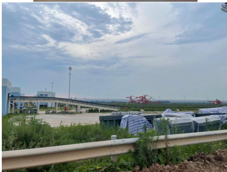
引桥皮带机挡风板
